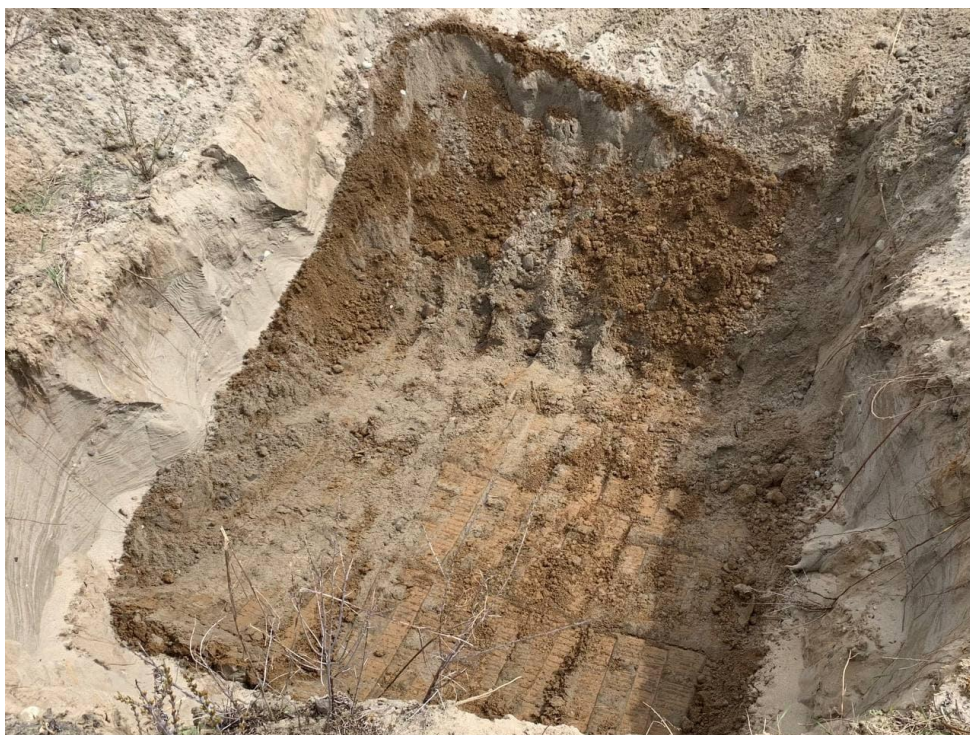
Рисунок 6. Формирование глиняного экрана на дне участка ОПИ.
